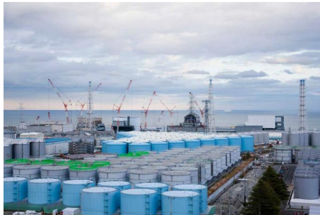
福島第一原発における ALPS 処理水貯蔵タンクの現状
