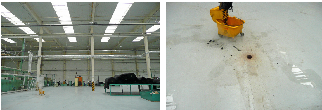
図 3.13 工場内の様子
