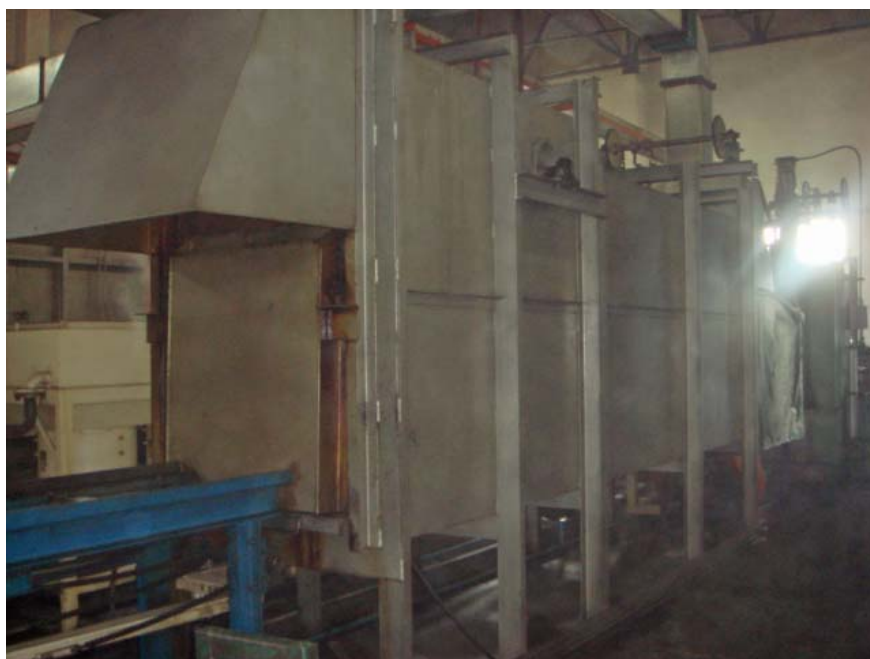
図 3-6 熱処理炉外観
